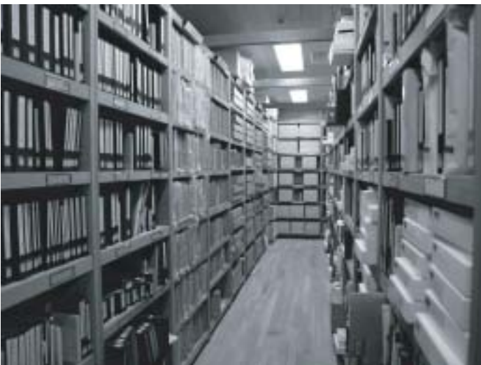
大阪市立中央図書館の貴重書庫 火災時には水を使わず二酸化炭素で消火します
